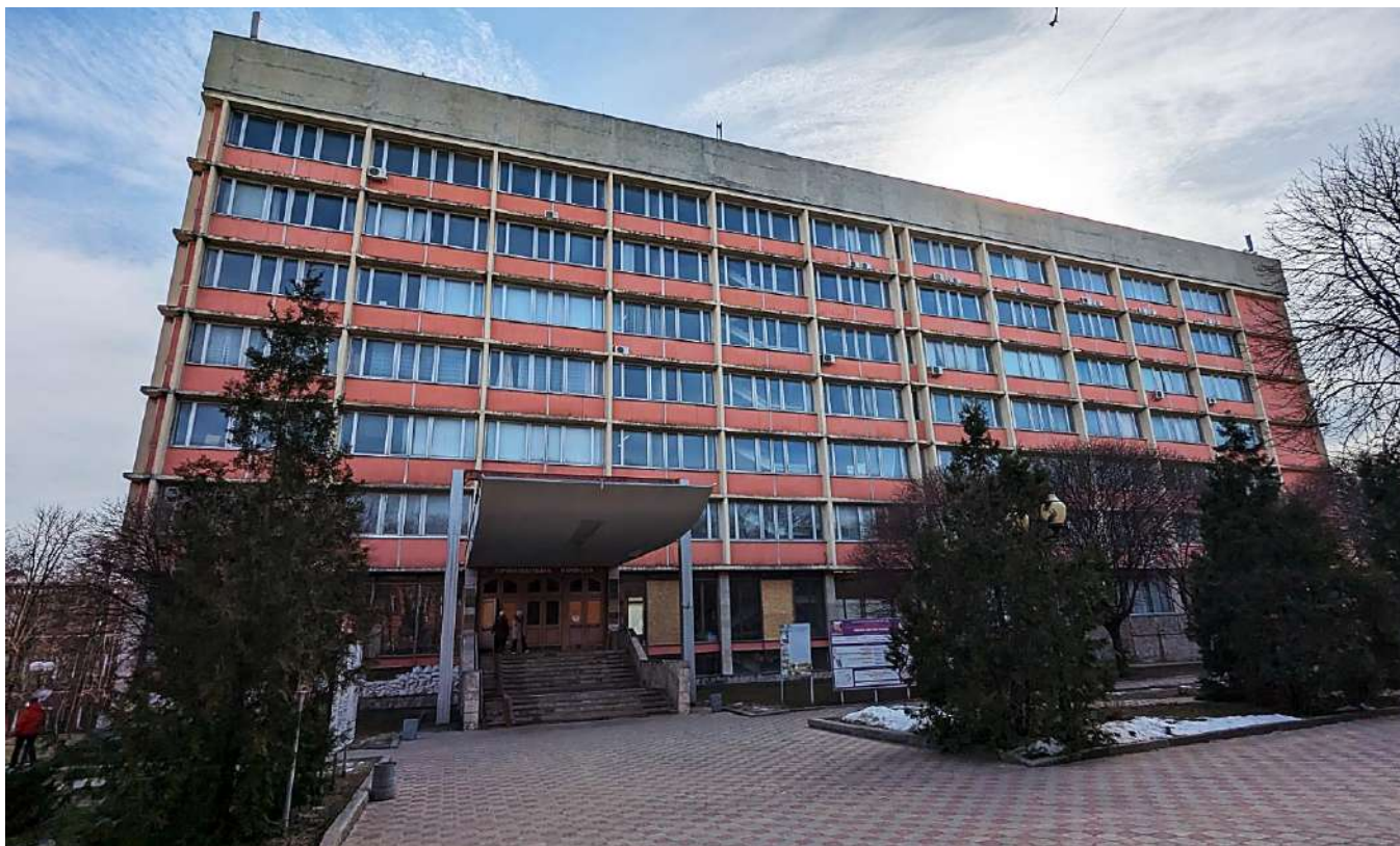
Рис. Б.1 Загальний вигляд будівлі
