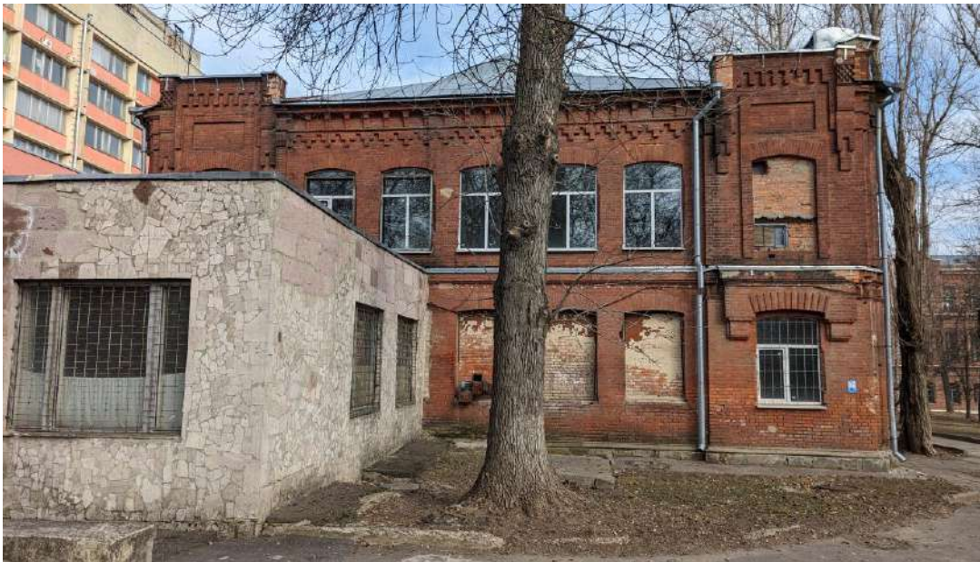
Примикання цокольної частини до фізичного корпусу
