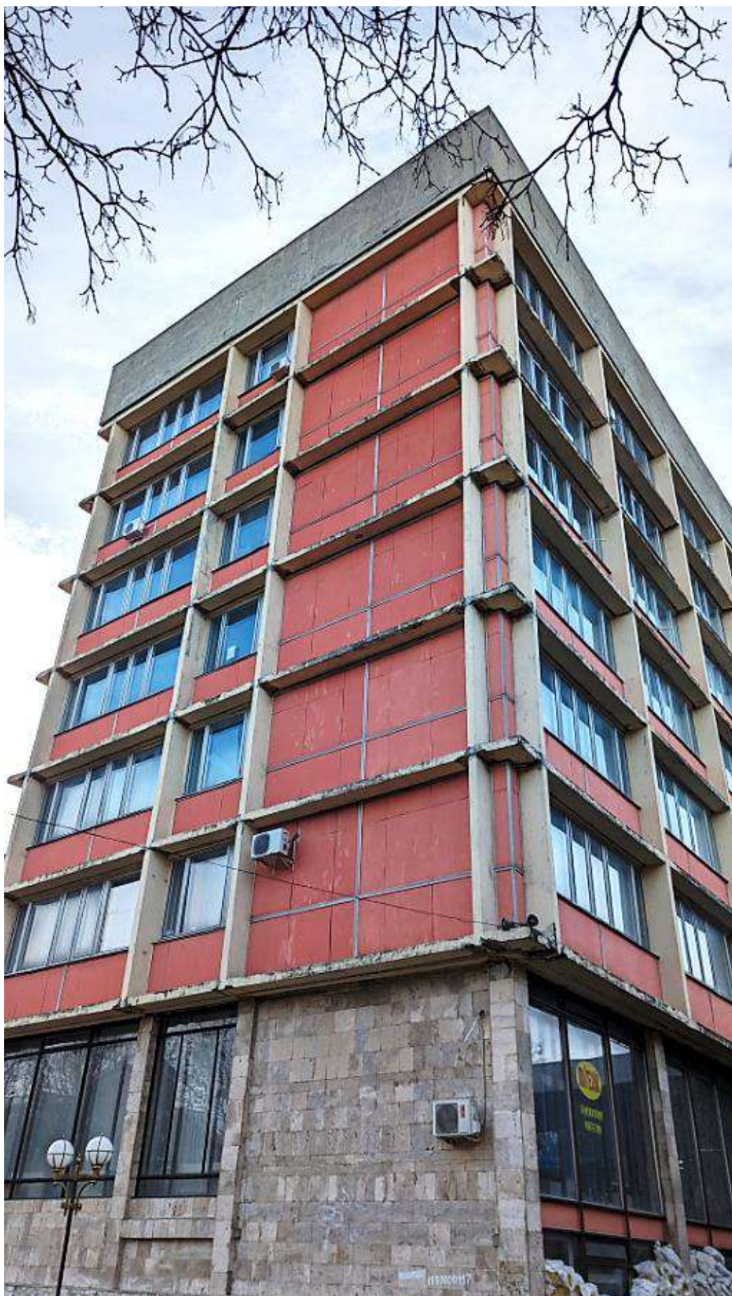
Рис. Б.4 Загальний вигляд будівлі
