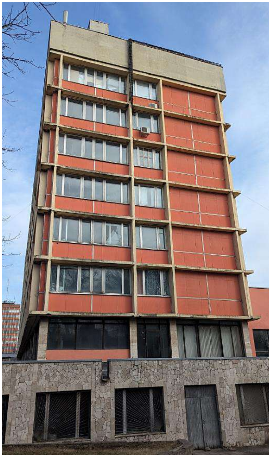
Рис. Б.3 Загальний вигляд будівлі
