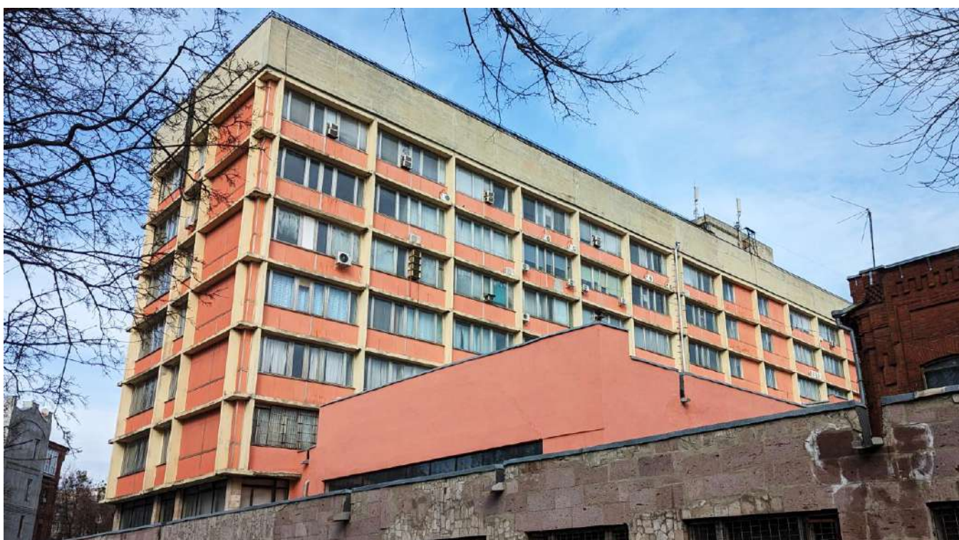
Рис. Б.2 Загальний вигляд будівлі
